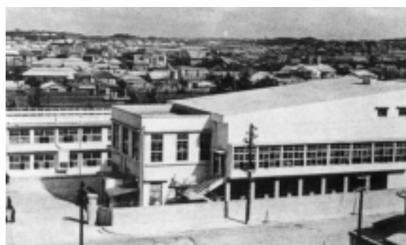
二中・那覇高校創立45周年記念事業として建設した 城岳同窓会館（昭和31年）
