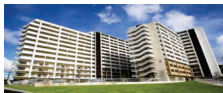
大名市営住宅
